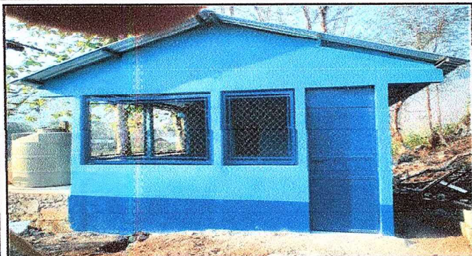
FOTO 1: AMPLIACIÓN Y REMODELACIÓN DE COCINA: Ampliación de la cocina del establecimiento educativo con el 80% de avance
