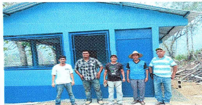
FOTO 2: EL AVANCE DE LA REMODELACIÓN DE LA COCINA: La ejecución lleva un proceso del 100%.
